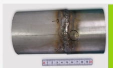
Rys. 1. Fragment rurociągu wody lodowej
