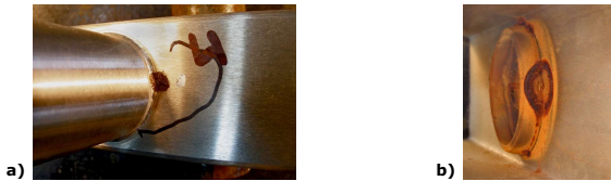
Rys. 2. Perforacja w obszarze spoiny elementu B, widok od strony zewnętrznej (a), widok od strony wewnętrznej (b)
