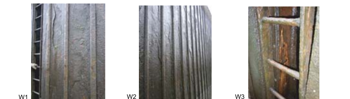
Rys. 8. Śluza Kłodnica Kędzierzyn Koźle. Przykłady korozji płytowej na ścianie wewnętrznej komory północnej śluzy (W1, W2) oraz całkowicie skorodowanego elementu we wnętrzu drabinki (W3)
