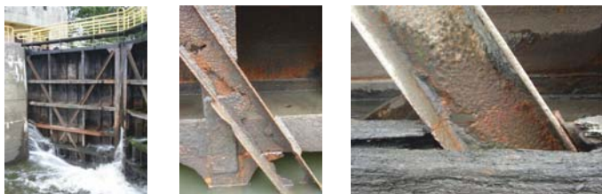
Rys. 2. Śluza w Brzegu Dolnym na rzece Odra. Widok całkowicie skorodowanych elementów skrzydła prawego bramy śluzy od strony wody dolnej
