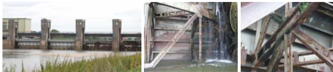
Rys. 8. Śluza Kłodnica Kędzierzyn Koźle. Przykłady korozji płytowej na ścianie wewnętrznej komory północnej śluzy (W1, W2) oraz całkowicie skorodowanego elementu we wnętrzu drabinki (W3)
