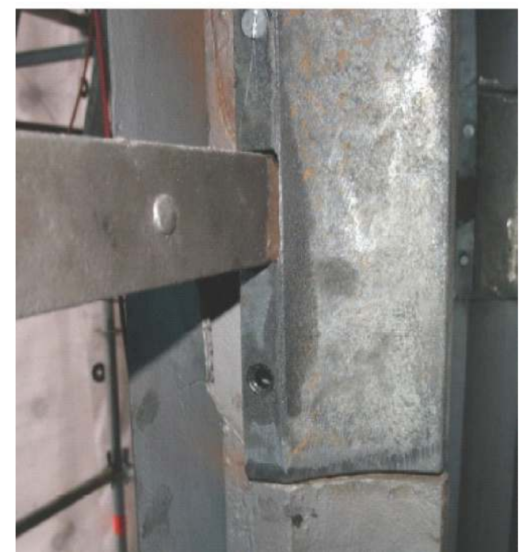
Rys. 4. Usztywnienie środkowego szpros za pomocą stalowych płaskowników. Nowe nakładki z żeliwa sferoidalnego
