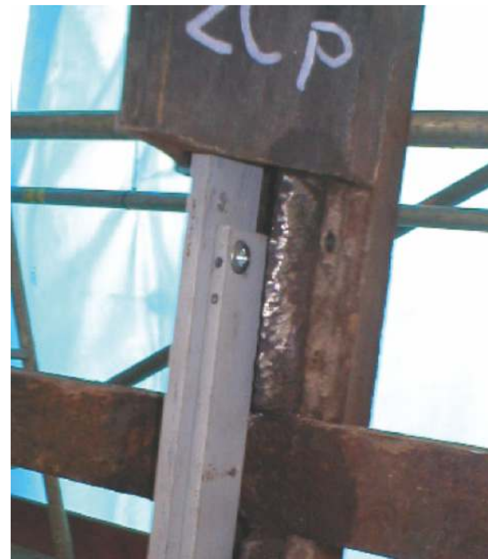
Rys. 4. Usztywnienie środkowego szpros za pomocą stalowych płaskowników. Nowe nakładki z żeliwa sferoidalnego
