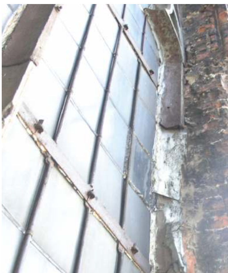
Rys. 2. Uszkodzenia konstrukcji okna od strony zewnętrznej i wewnętrznej
