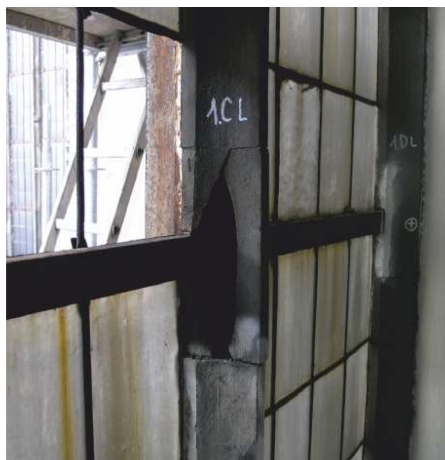
Rys. 2. Uszkodzenia konstrukcji okna od strony zewnętrznej i wewnętrznej
