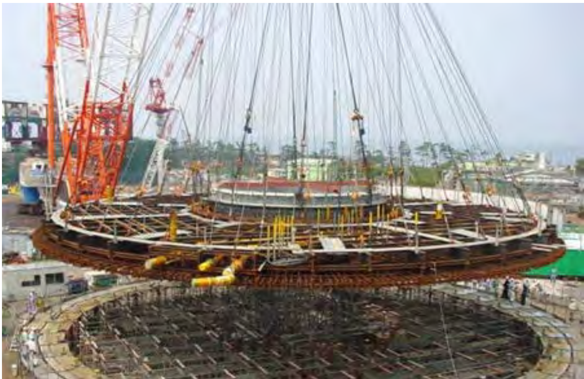
Rys. 21. Top Slab Module reaktora ABWR firmy GE Hitachi [26]
