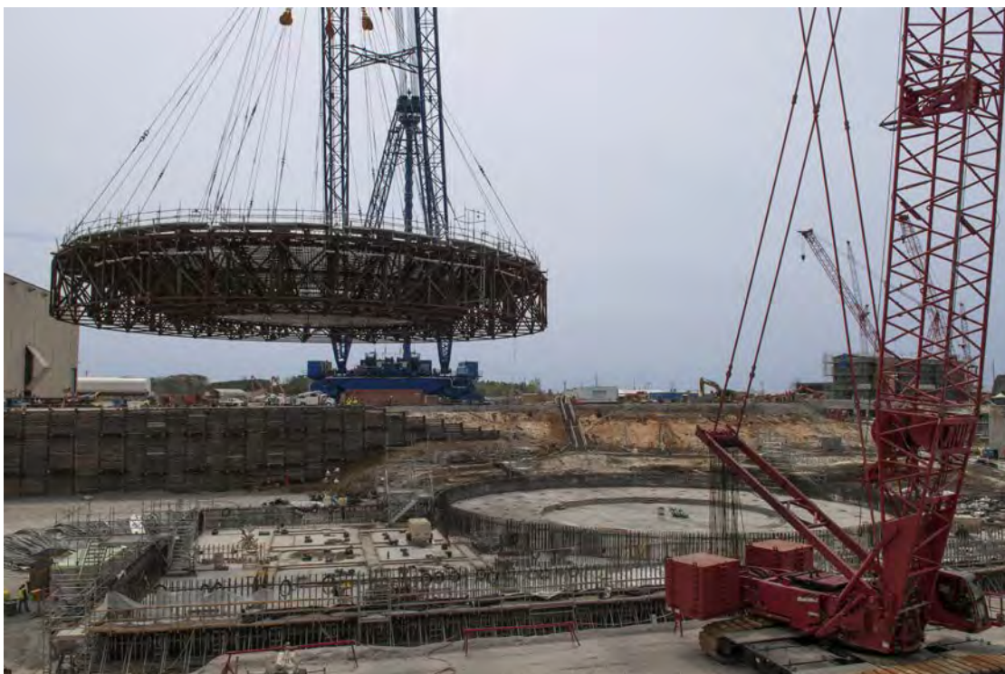
Rys. 15. Moduł CR-10 do ustawienia dennicy płaszczu reaktora AP1000 na placu budowy elektrowni V. C. Summer Unit 2 [22]
