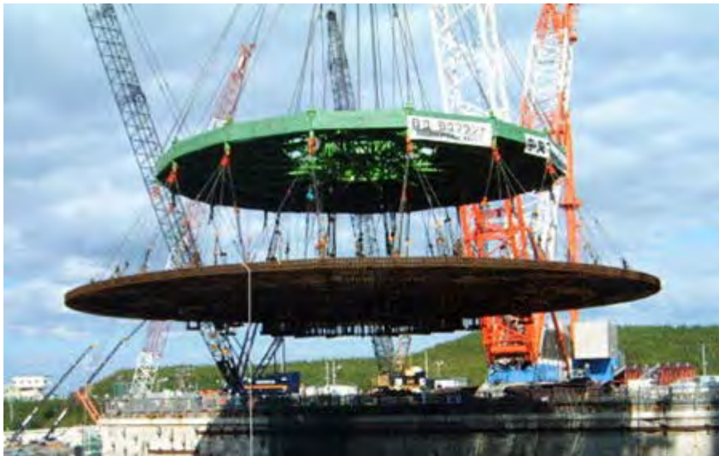
Rys. 19. Base Mat Module reaktora ABWR firmy GE Hitachi [26]
