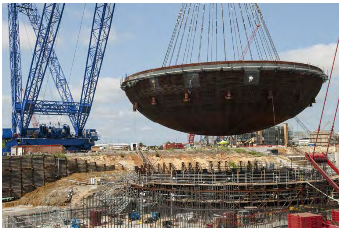
Rys. 16. Montaż części dolnej płaszczu reaktora AP1000 na placu budowy elektrowni V. C. Summer Unit 2 [23]
