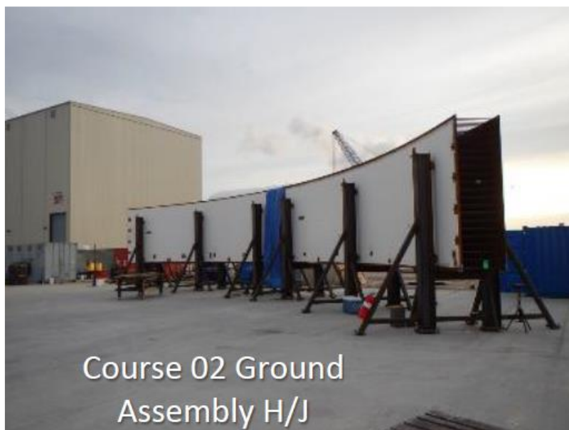
Rys. 11. Prefabrykacja stalowych paneli osłony zewnętrznej reaktora AP1000 [37].
