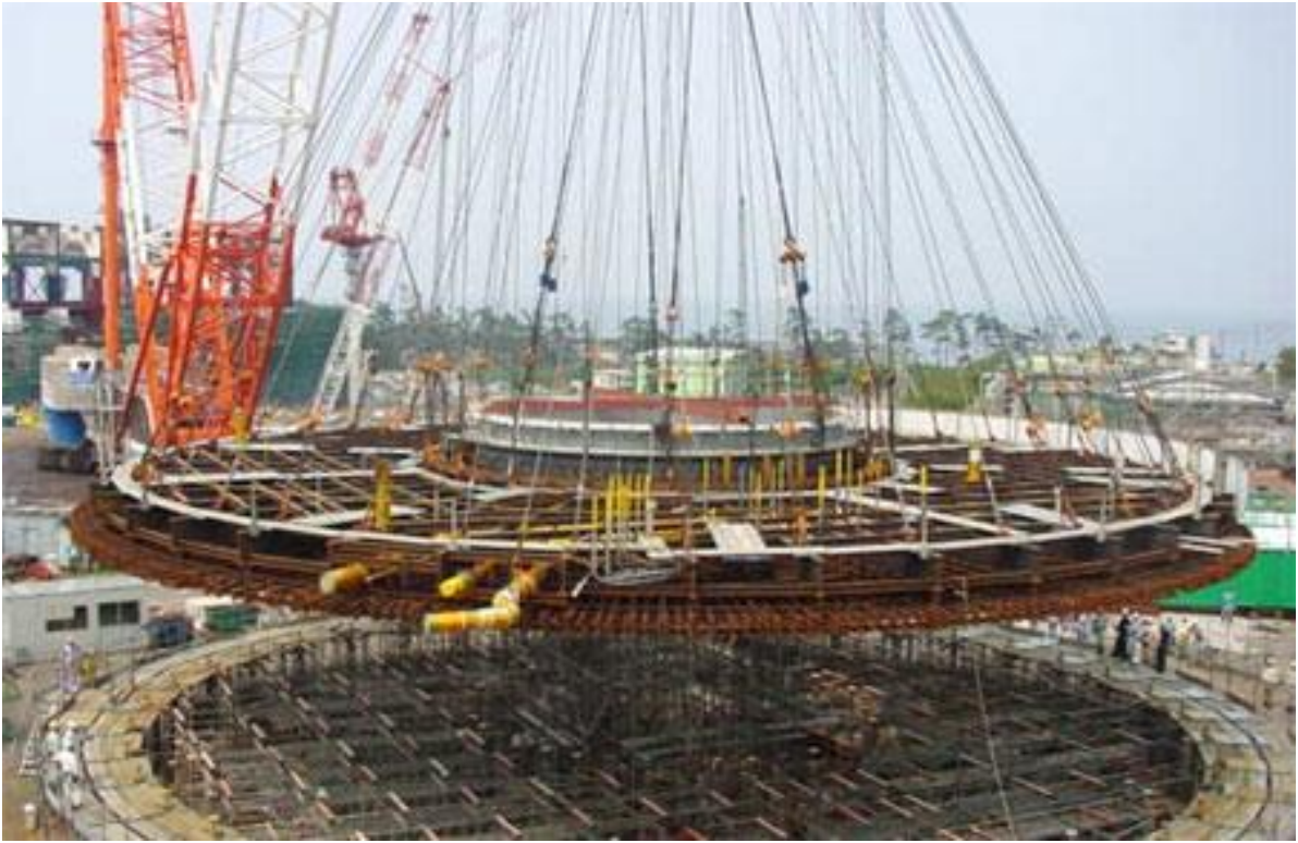
Rys. 19. Top Slab Module reaktora ABWR firmy GE Hitachi [54].
