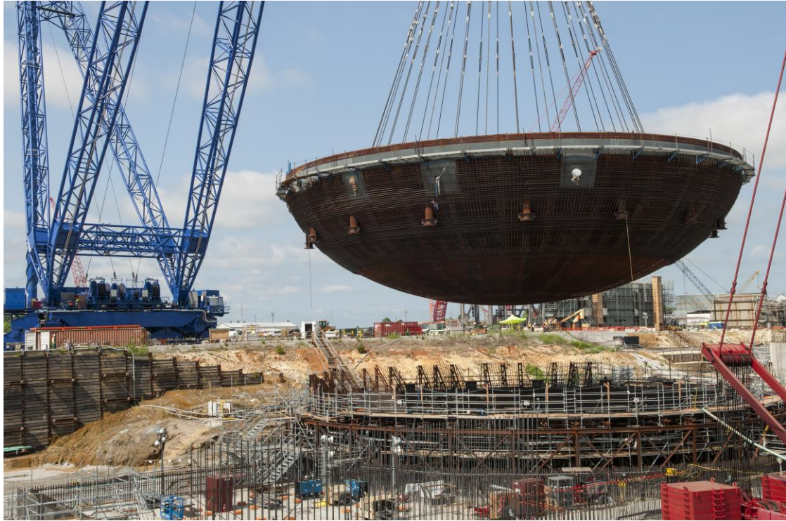
Rys. 9. Montaż części dolnej płaszczu reaktora AP1000 na placu budowy elektrowni V. C. Summer Unit 2 [35].
