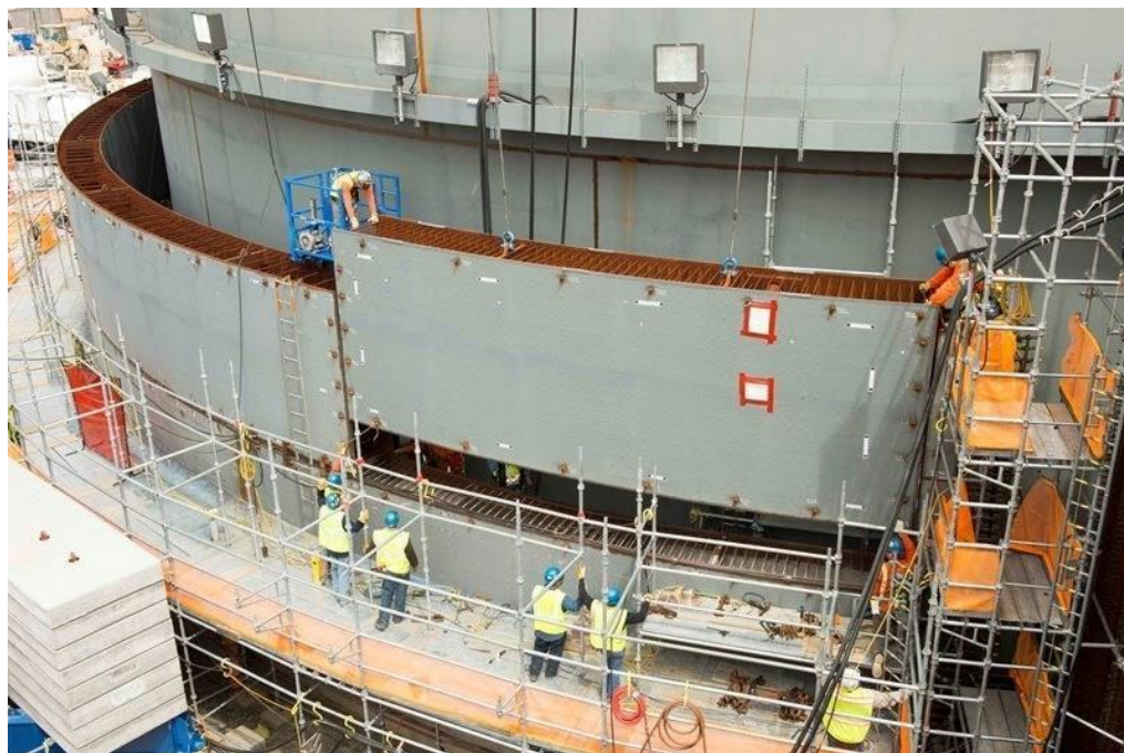
Rys. 12. Montaż stalowych paneli zewnętrznej osłony reaktora AP1000 na placu budowy Vogtle 3 [38].
