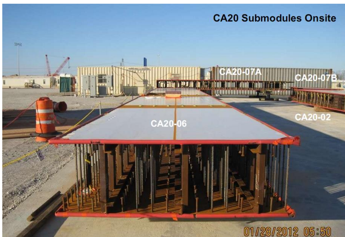
Rys. 13. Prefabrykowany sub-modul CA20-06 dla Vogtle 3 [39].
