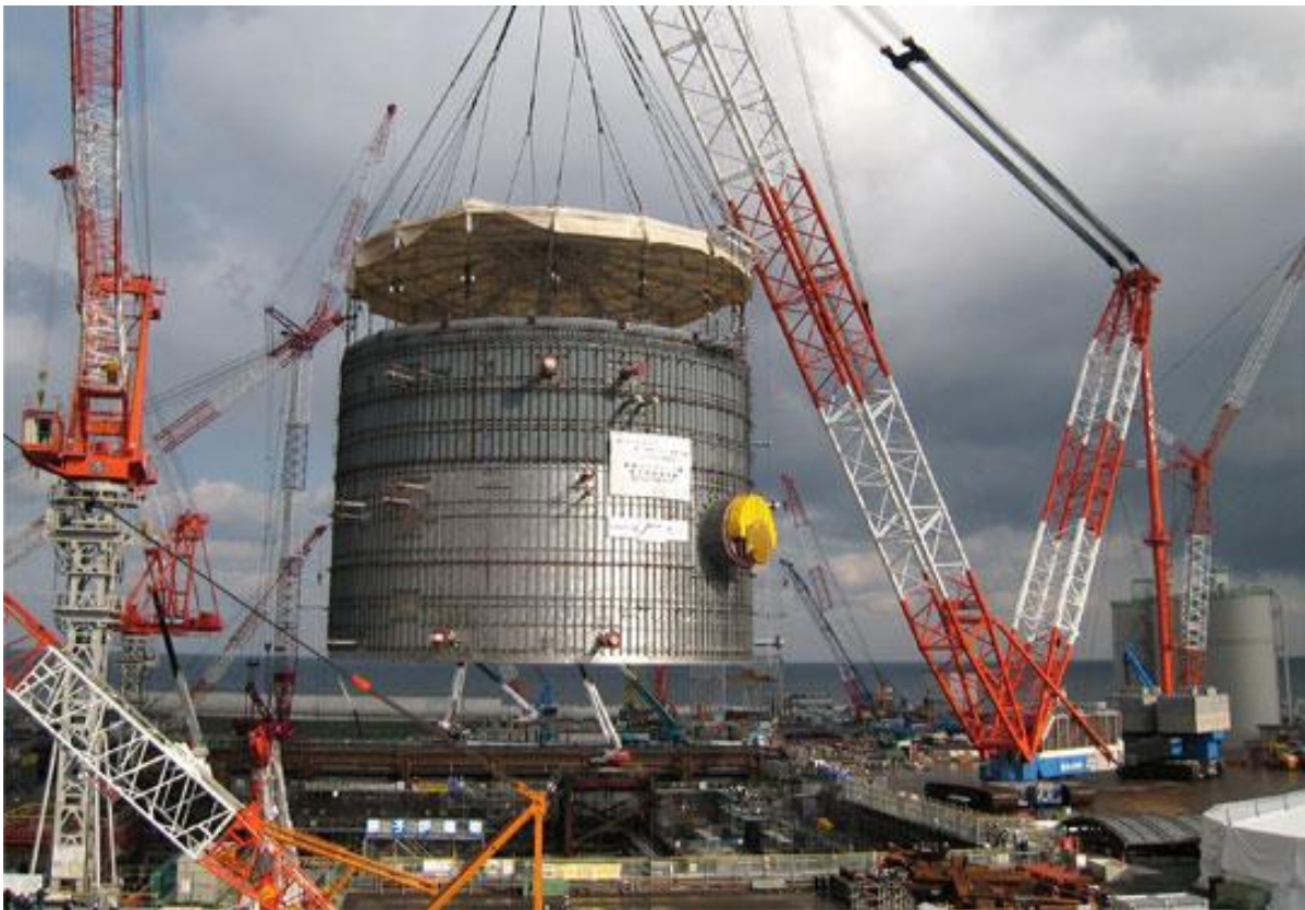
Rys. 17. Dolny pierścień cylindryczny płaszczu stalowego (RCCV Lower Liner Module) reaktora ABWR firmy GE Hitachi [53].
