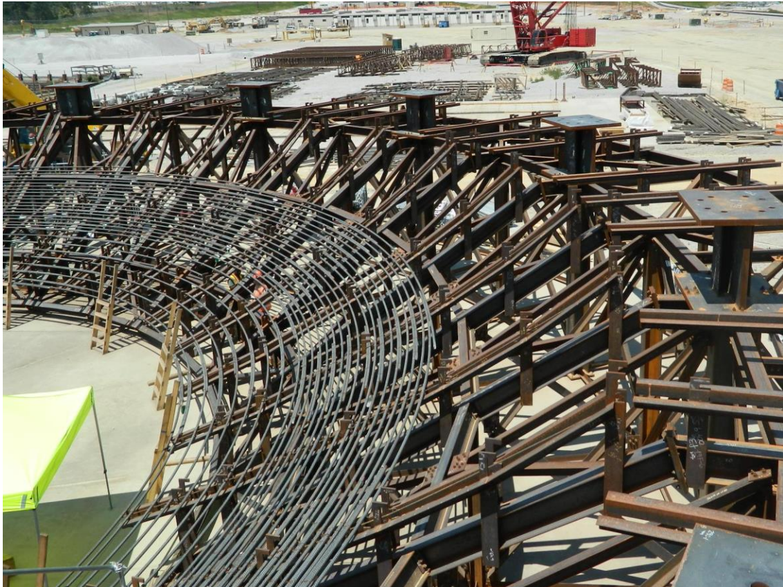
Rys. 10. Fragment modułu CR-10 na placu budowy V. C. Summer Unit 2 [36].
