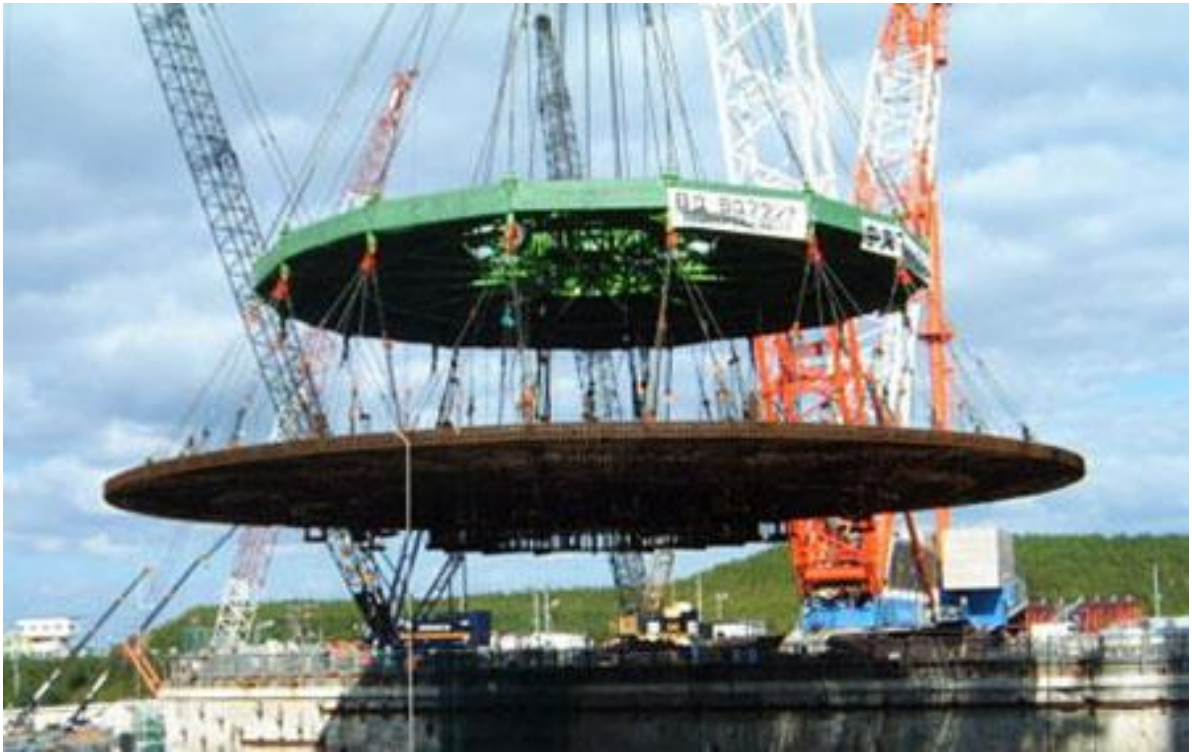
Rys. 18. Base Mat Module reaktora ABWR firmy GE Hitachi [54].
